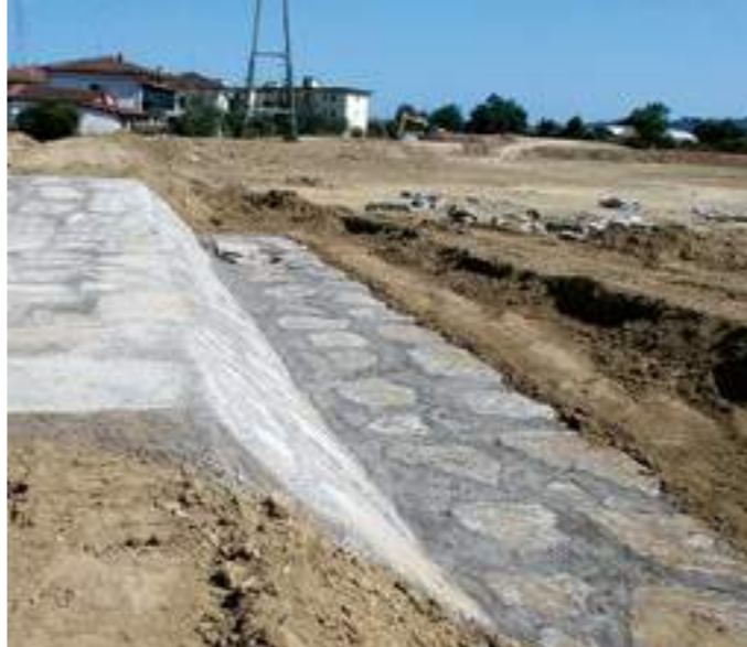
Lavori urgenti di ripristino del corpo stradale della SS64 "Porrettana", franato in località Pavana, 2019-2021.
